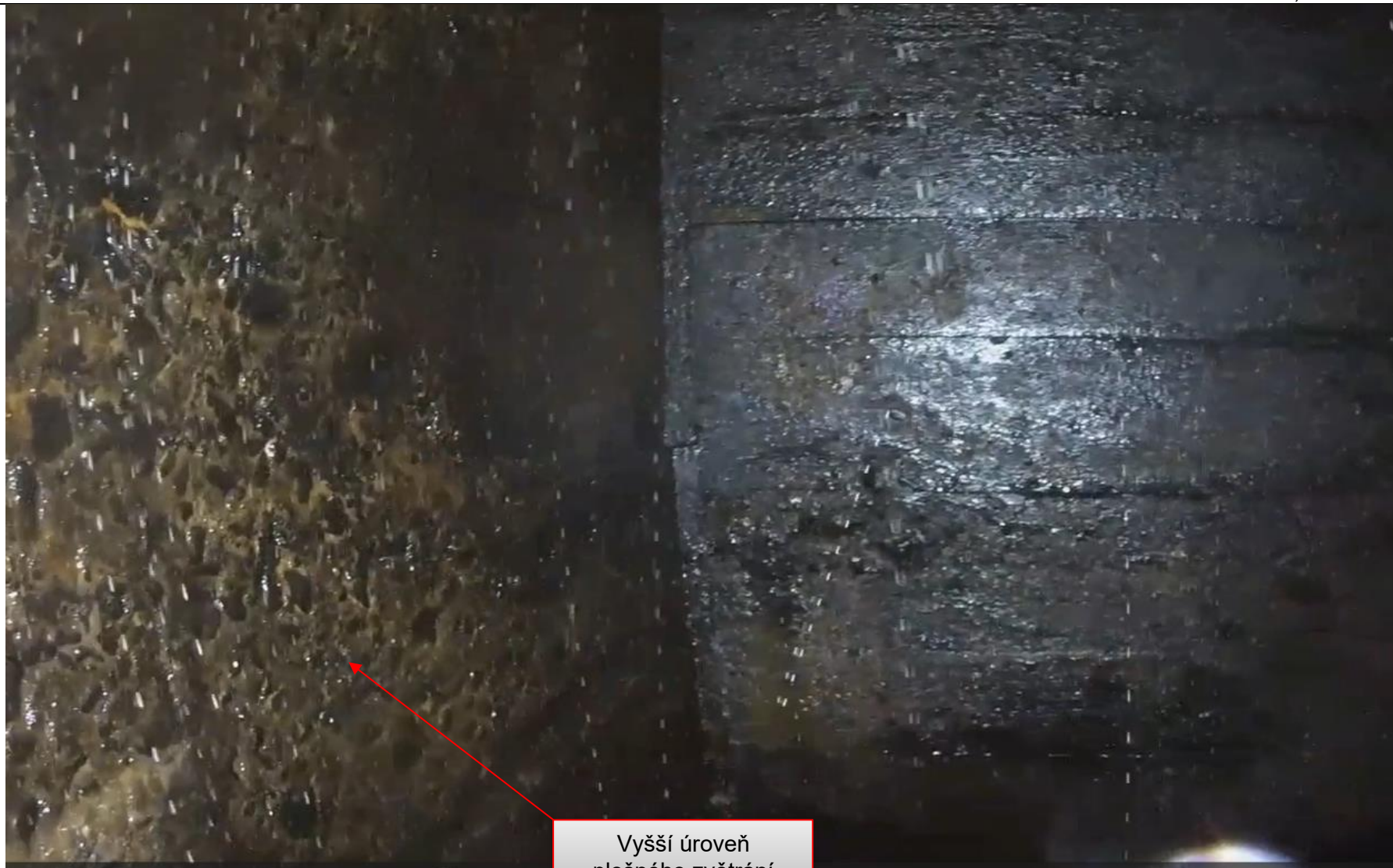
Photo №4: Pohled na Východní stěnu v úrovni 2,5m pod horním víkem štoly. Východní stěna je výrazně více degradována okolními vliv.
