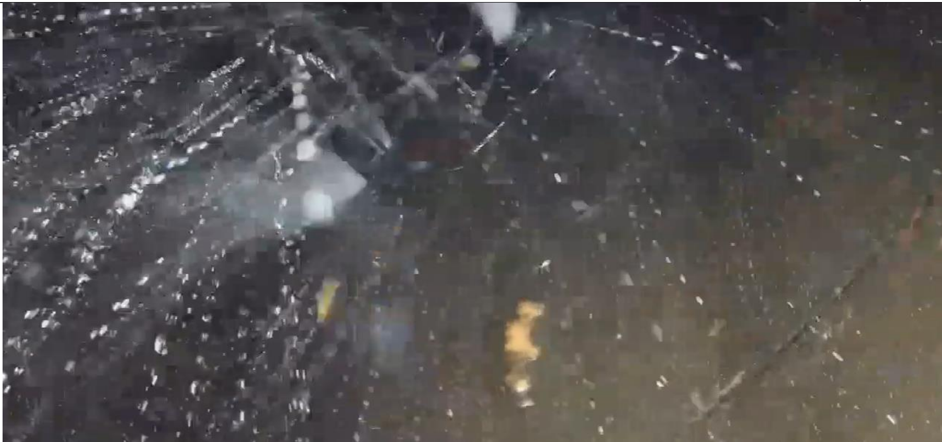
Photo №12: Pohled ze spodu na místo průsaku v 6 m na západní stěně. Z fotografie a z přiloženého video je jasně patrné, že průsak je již značně pod tlakem.
