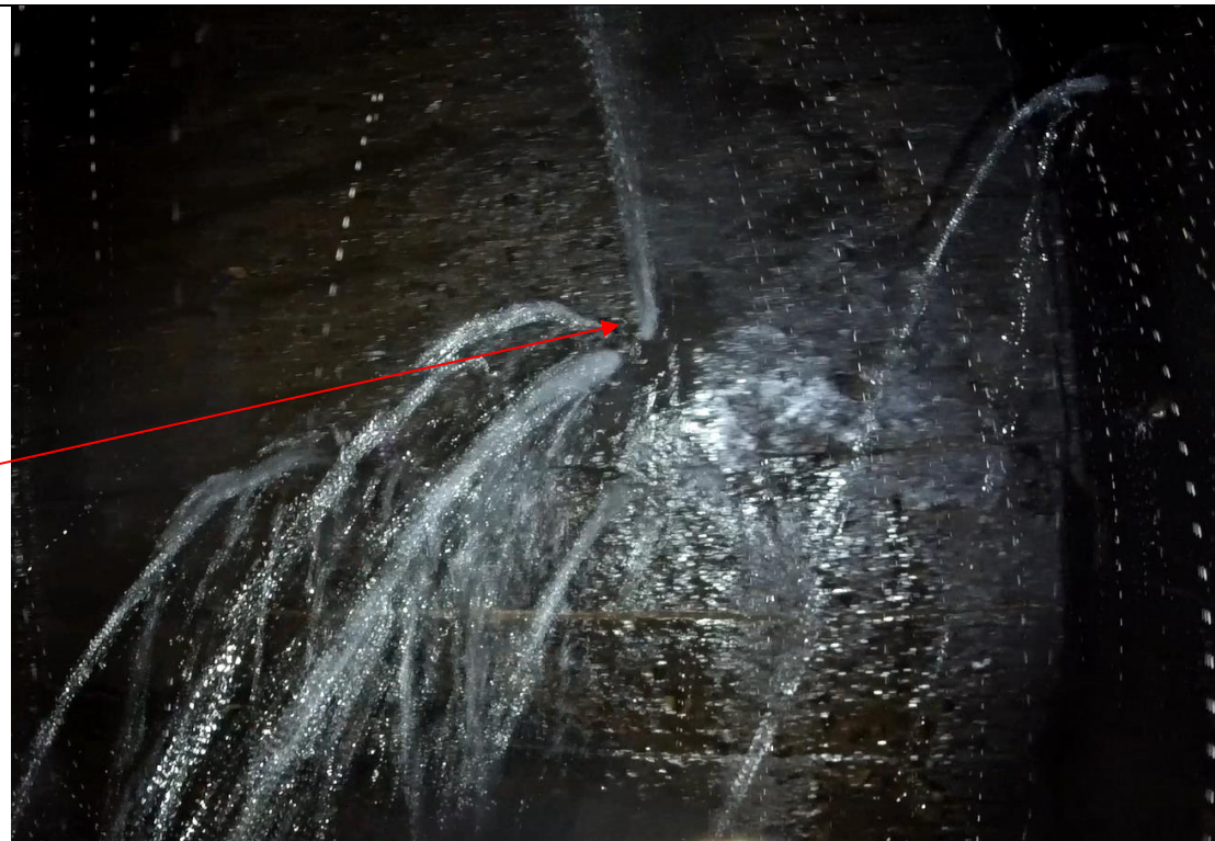
Photo №7: Detailní pohled na místo průsaků v hloubce 2,5m z roku 2024 . Progres poškození je jasně viditelný. Průsak se rozšířil a nyní tryská pod větším tlakem.
