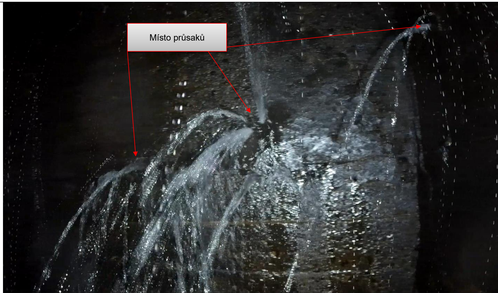
Photo №5: Detailní pohled na místo s průsaky. Na severní a západní stěně štolý zhruba v hloubce 2,5m.
