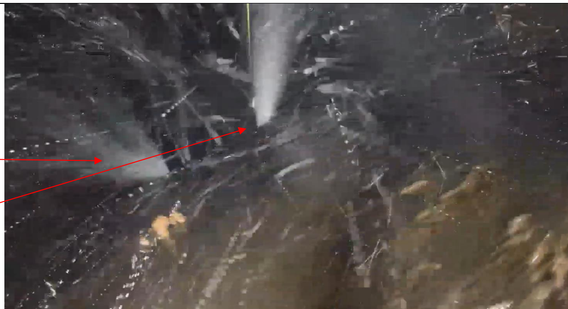
Photo №11: Porovnávací pohled na místo průsaku v hloubce 6 m z roku 2024 . Rozšíření průsaku je patrné.
