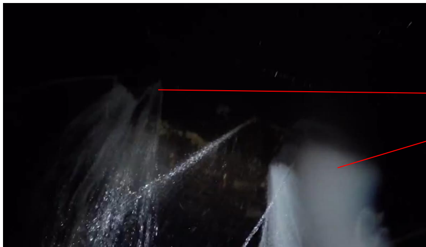
Photo №10: Detailní pohled na místo průsaků v hloubce 6 m z roku 2015 .
