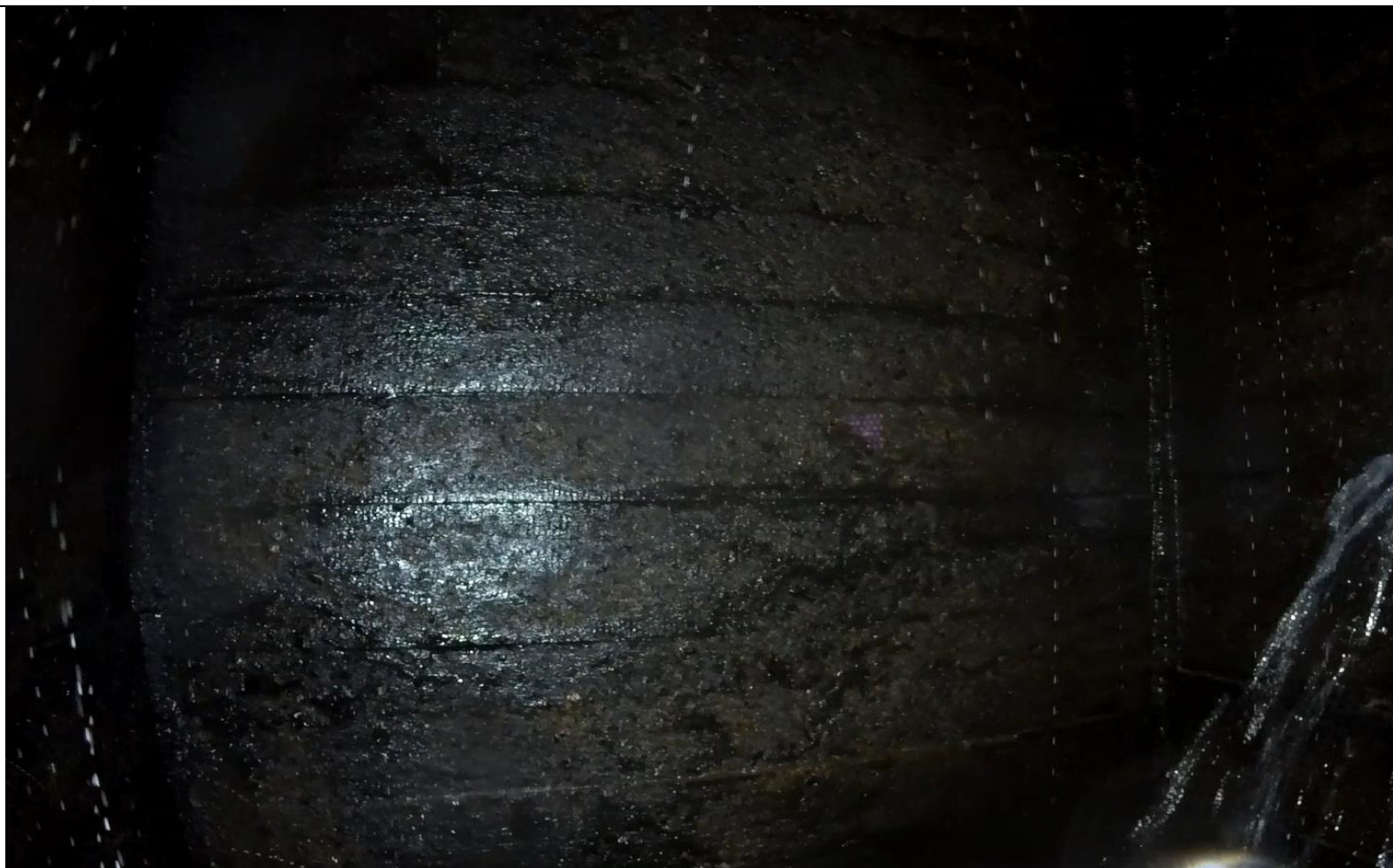
Photo №3: Pohled na jižní stěnu v úrovni 2,5m pod horním víkem štoly. Jižní stěna bez viditelných průsaků.
